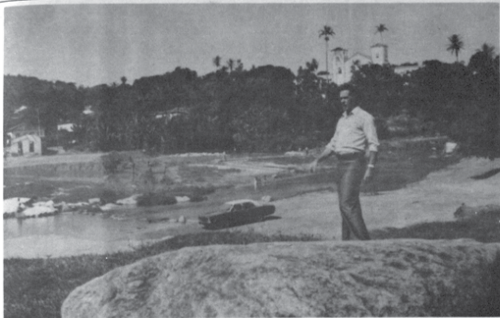
Nelito supervisiona obras da "Beira-Rio"
